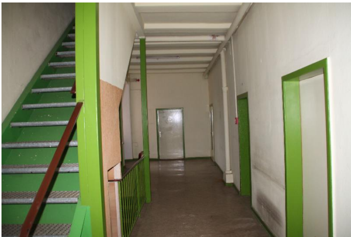
Nördliches Treppenhaus, 1. OG
